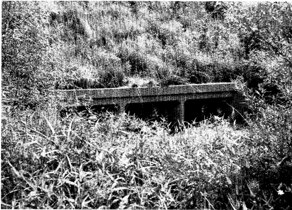
N. C. Hwy. 18 Culvert
